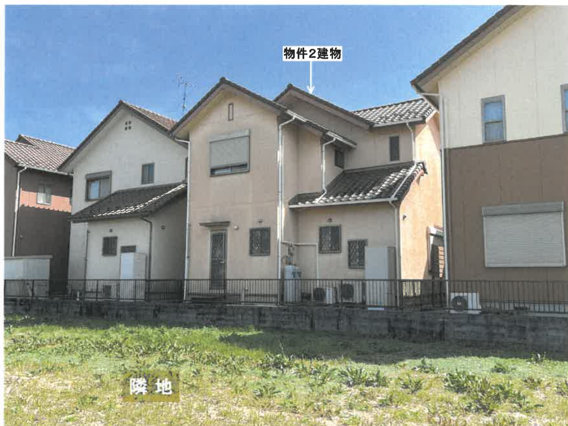
写真③ 北西方より撮影
