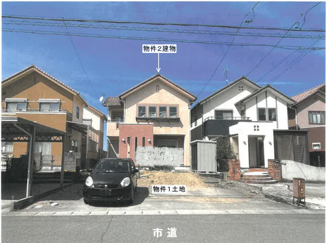
写真① 南方より撮影
