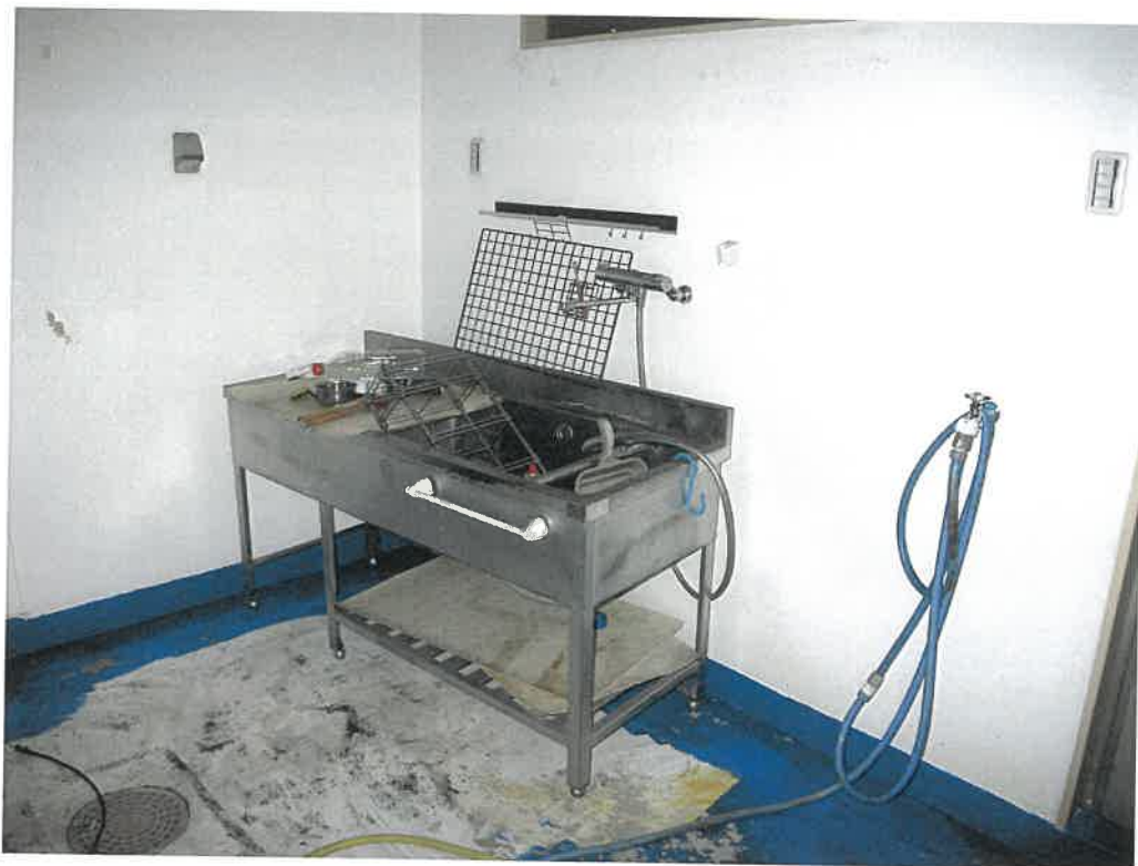
前同建物の1階室内
