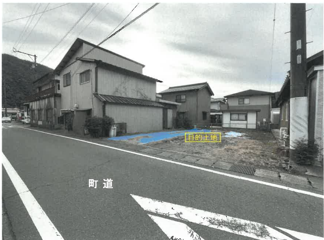
写真② 東側町道より撮影
