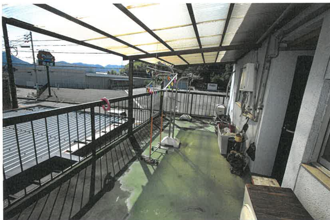
物件 5 主建物 3 階ベランダ
