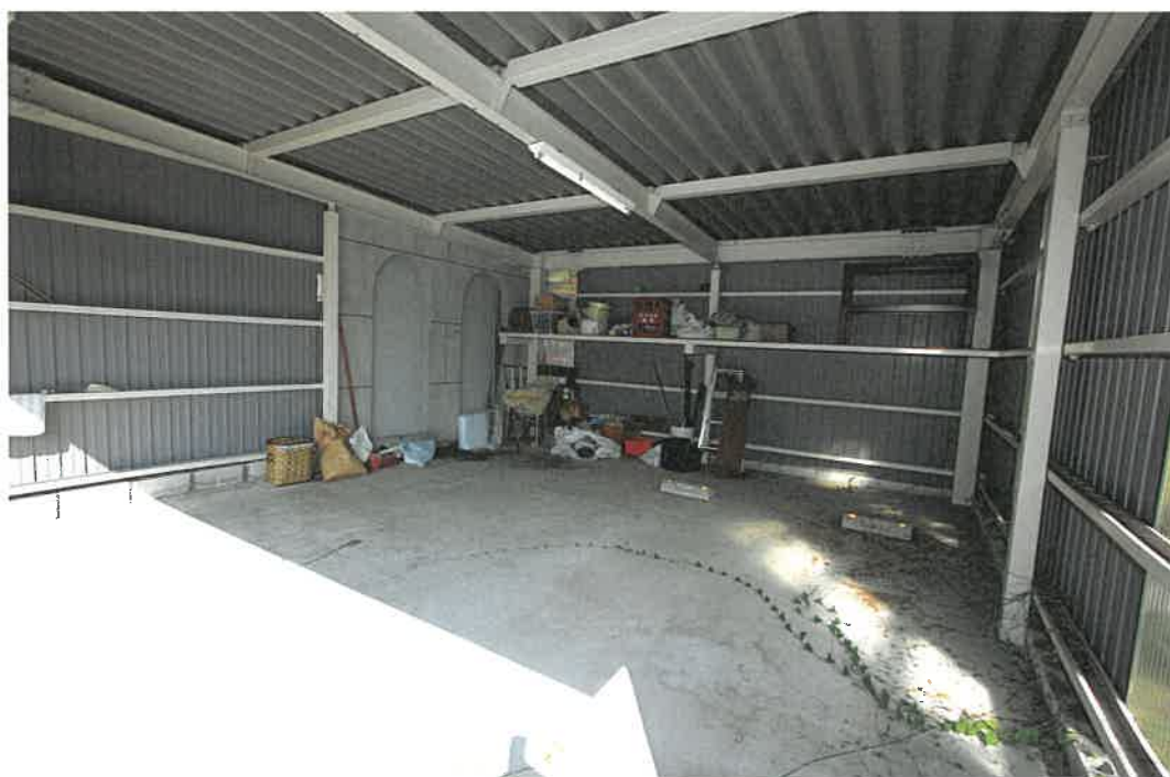
物件 5 附属建物 1 室内
