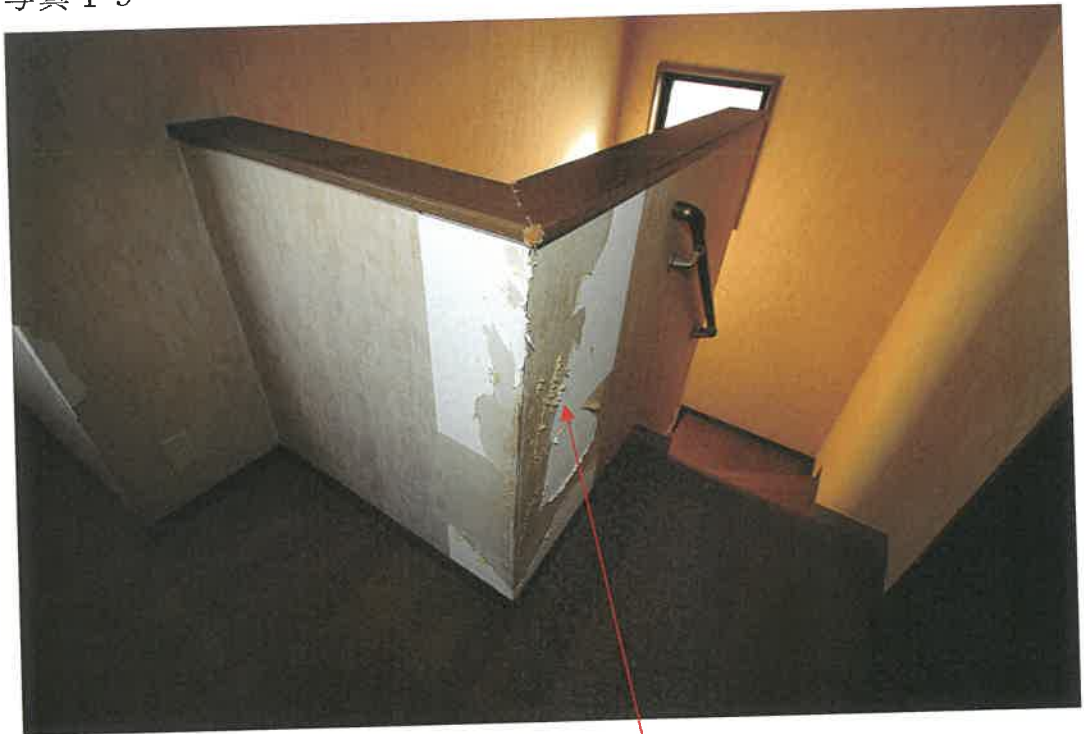
物件 2 建物 2 階室内
