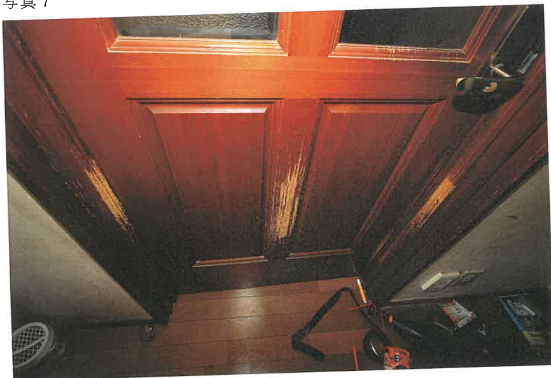
物件 2 建物 1 階室内
