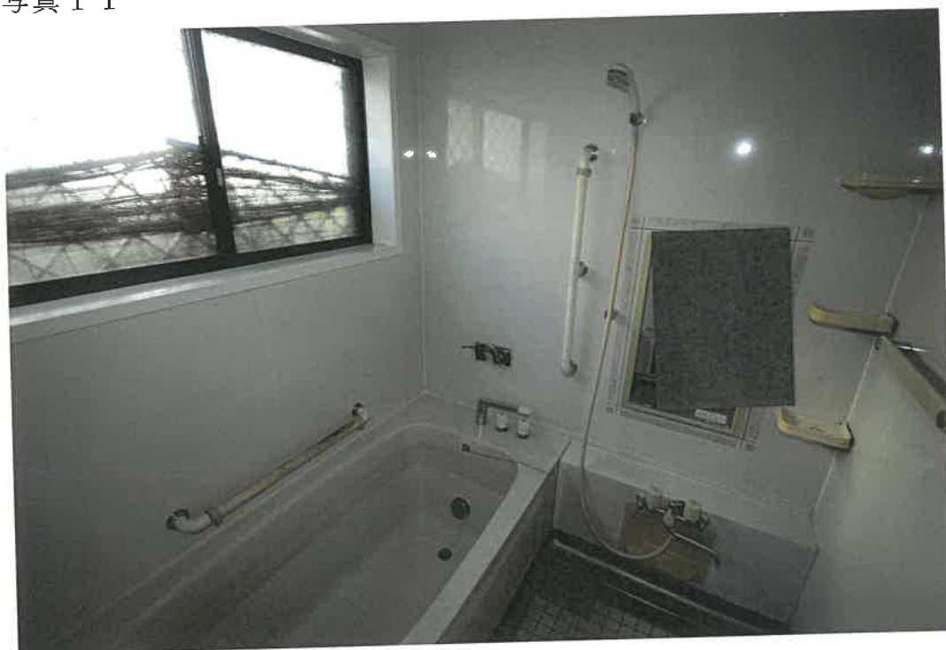
物件 2 建物 1 階室内
