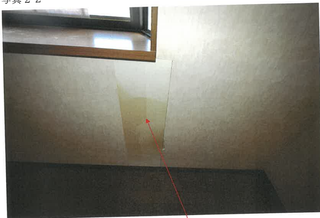
物件 2 建物 2 階室内
