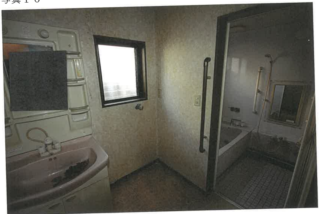
物件 2 建物 1 階室内
