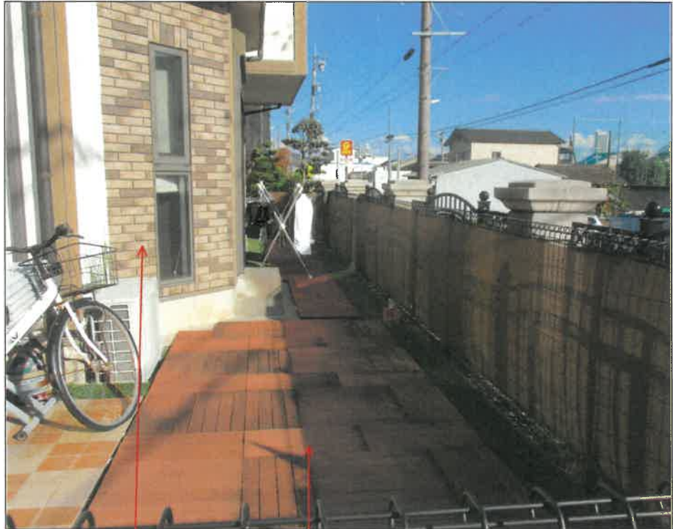
物件2建物 デッキ
