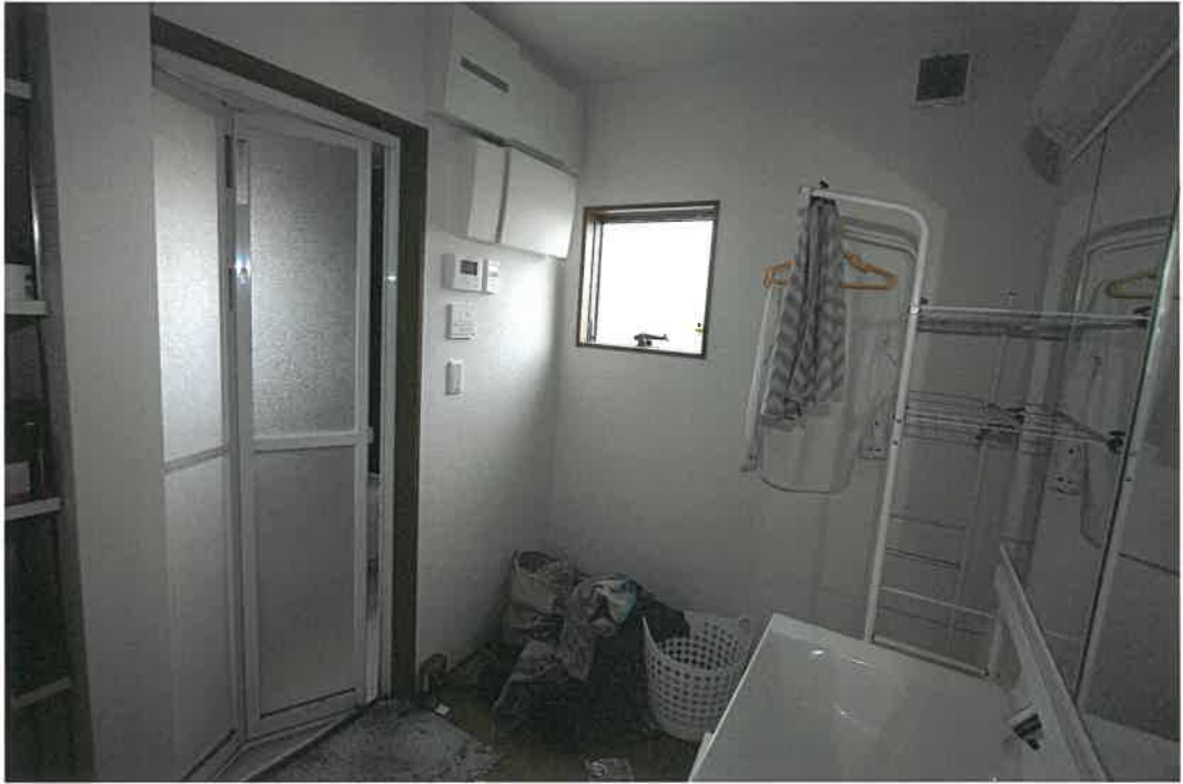
物件 2 建物 1 階室内
