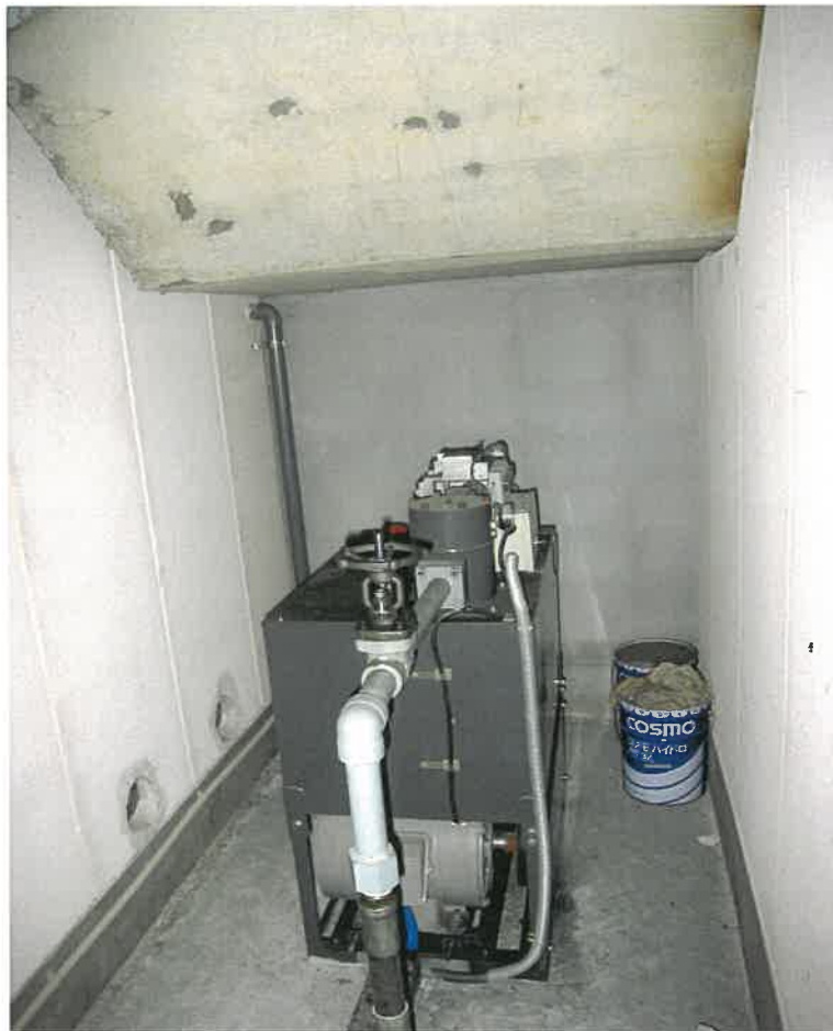
前同建物の1階動力室内
