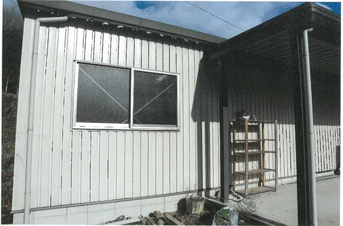
物件4 建附属建物の外壁の状況
