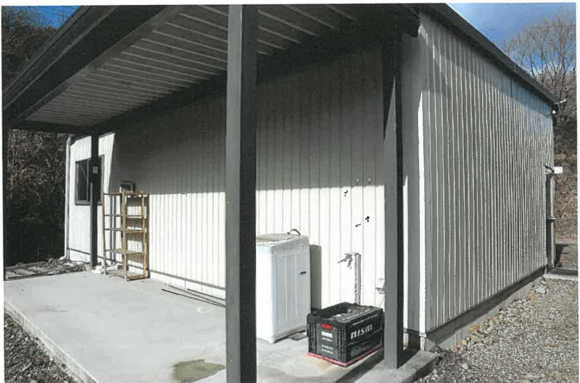
物件 4 建附属建物の外壁の状況
