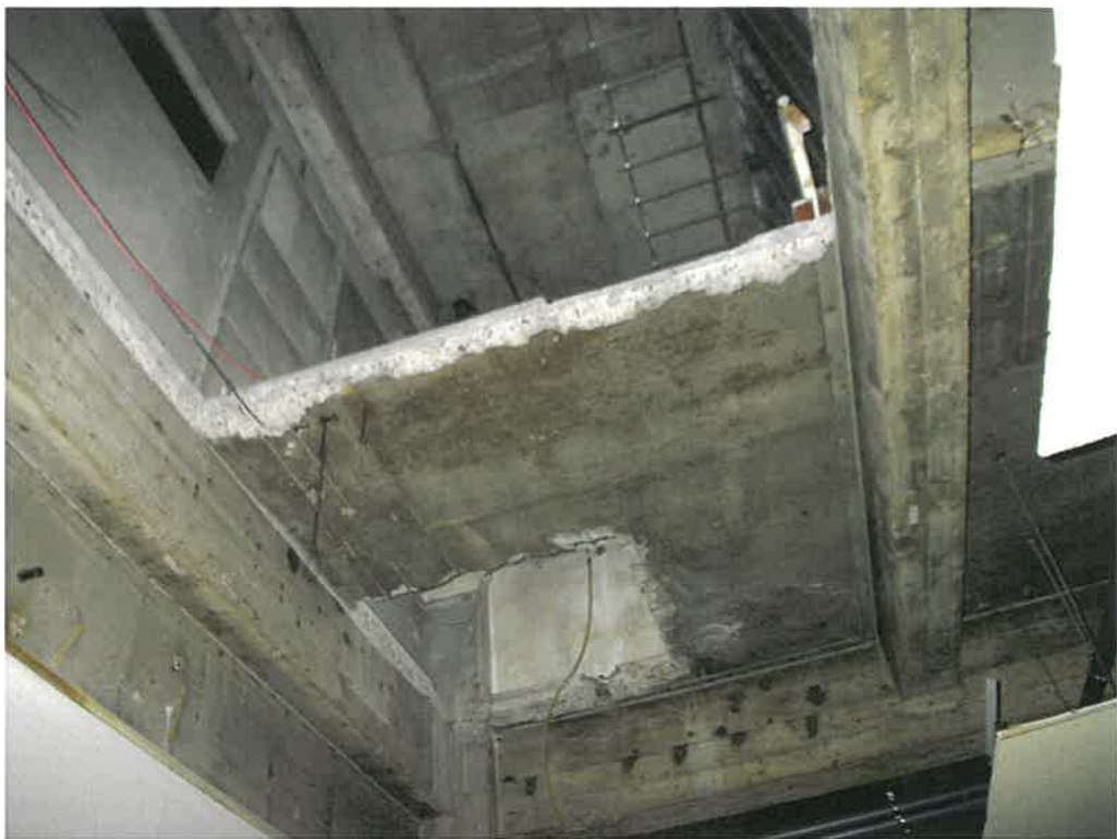
前同建物の1階室内（天井）
