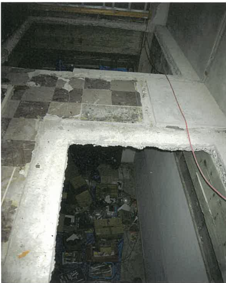
前同建物の2階テラス側からの1階天井部分
