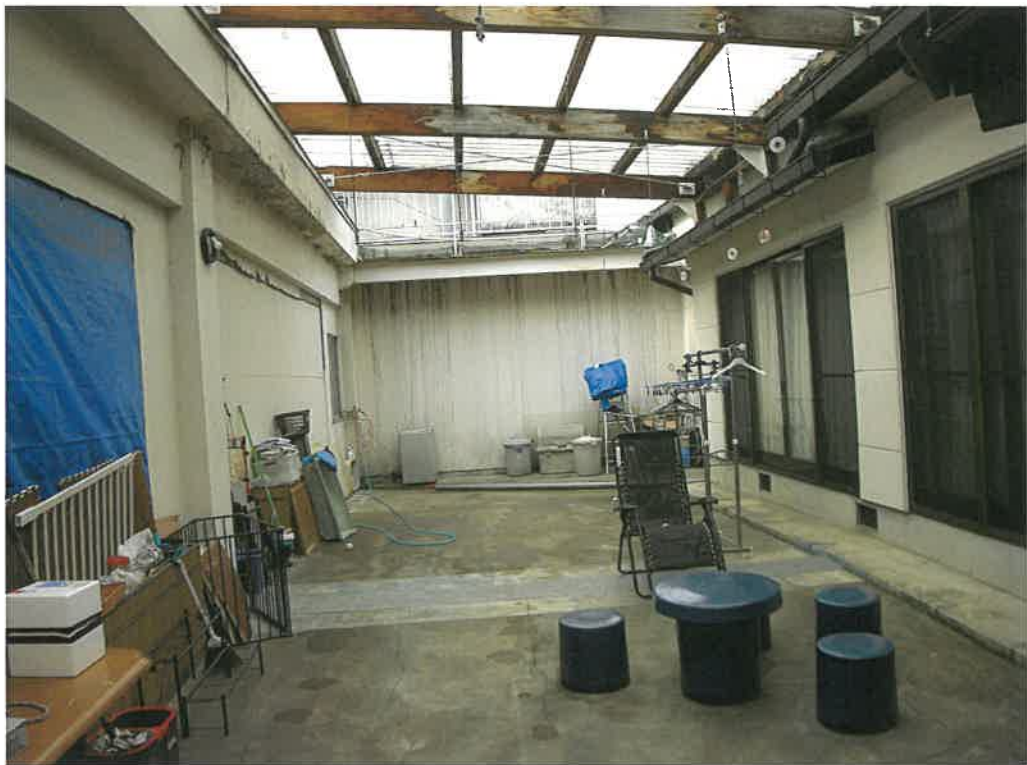
前同建物の2階テラス内
