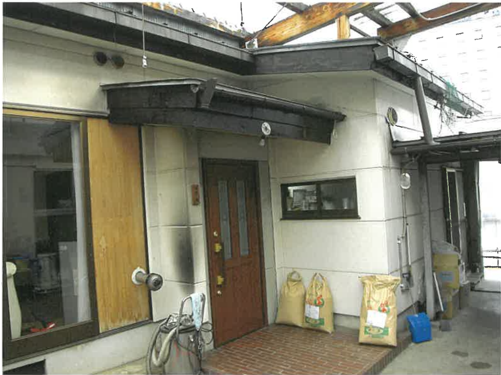
前同建物の2階北側住宅部分
