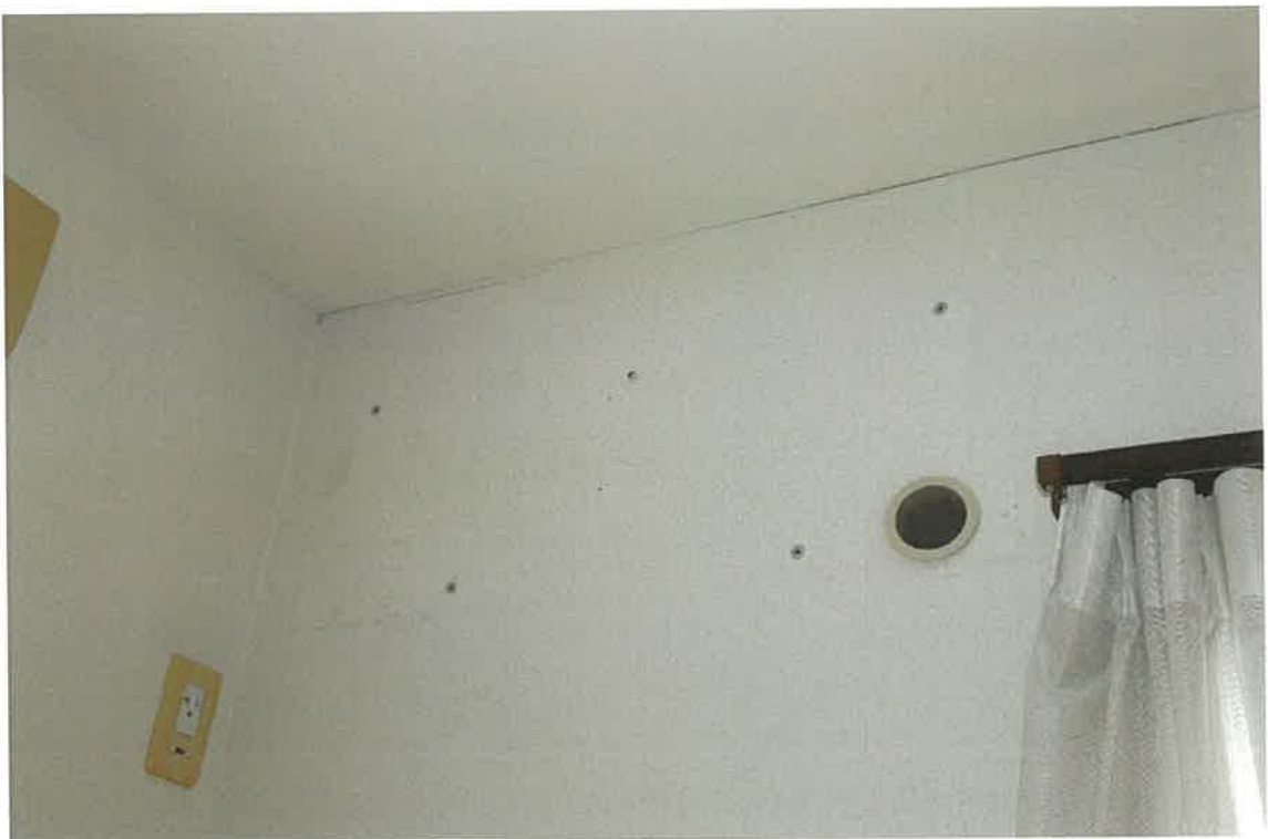
写真1 2 物件2建物2階南東側洋室内のエアコンを取り外した跡
