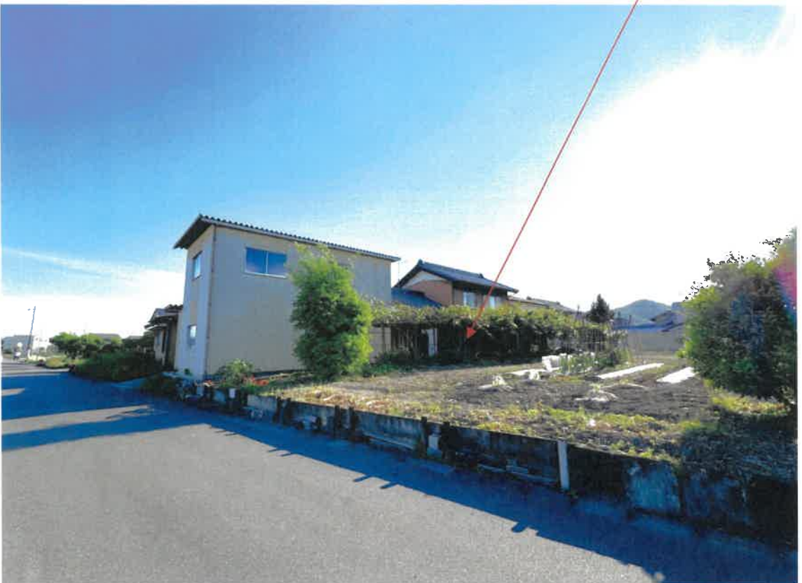
目的物件の現況写真
