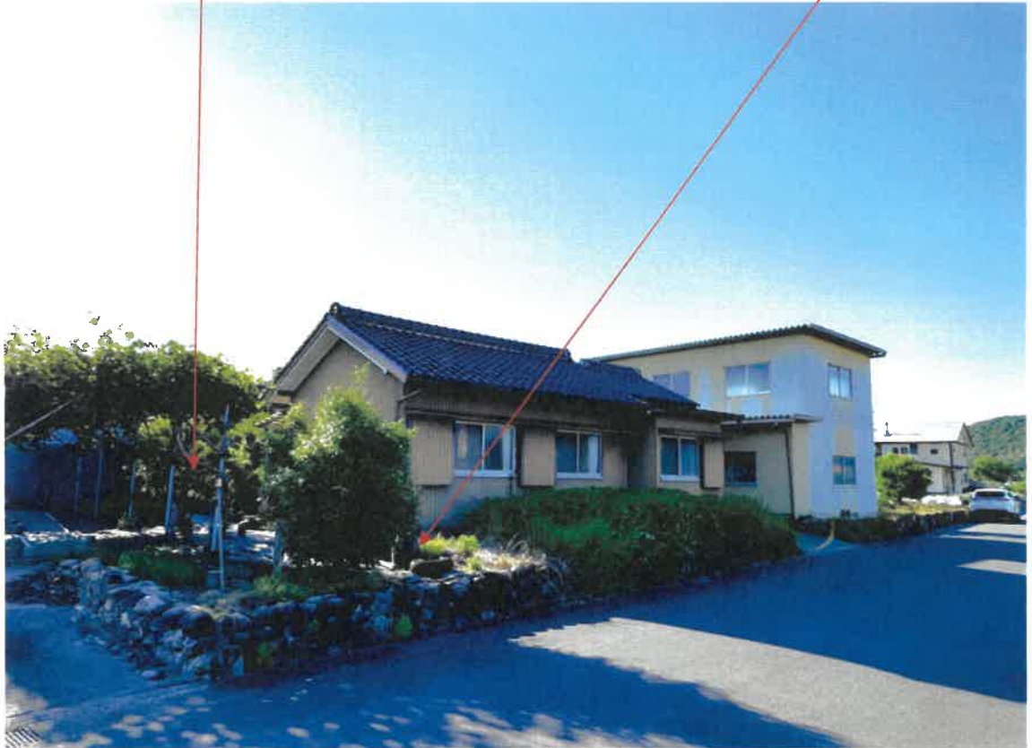
目的物件の現況写真
