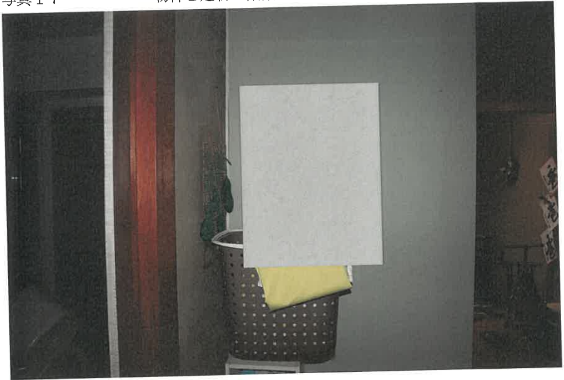
物件2建物1階階段部分を封鎖している状況
