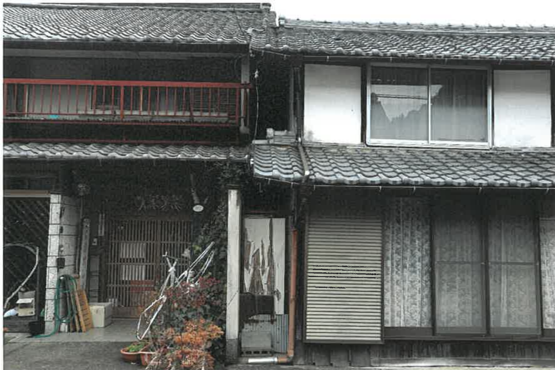
写真29 物件4主建物の屋根の庇の一部が物件2, 3土地の南東側の隣地(地番98番6, 同99番)上に, 同隣地上の建物の屋根の庇の一部が物件3土地の上に相互に越境しているものと思料する状況
