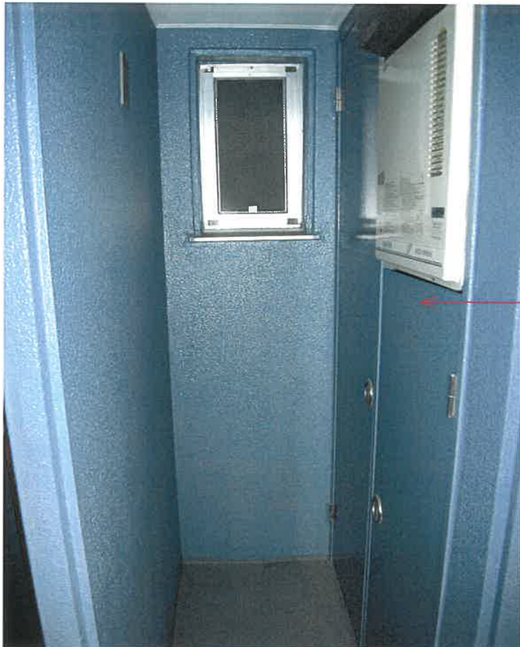
前同建物のパイプスペース
