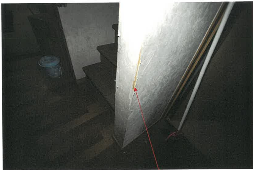
物件 2 建物 1 階室内
