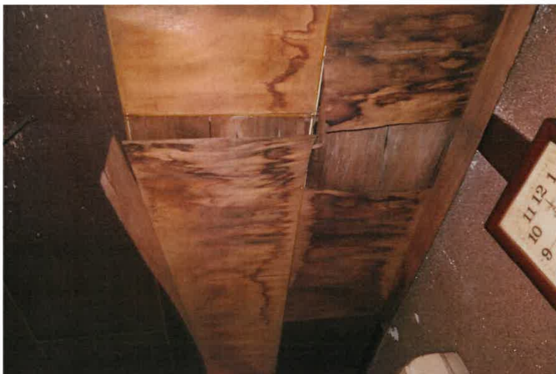
撮影方向：物件4の1階北側和室の天井付近
