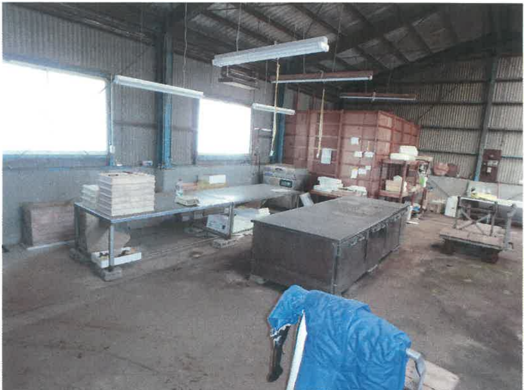
物件8建物の内部
