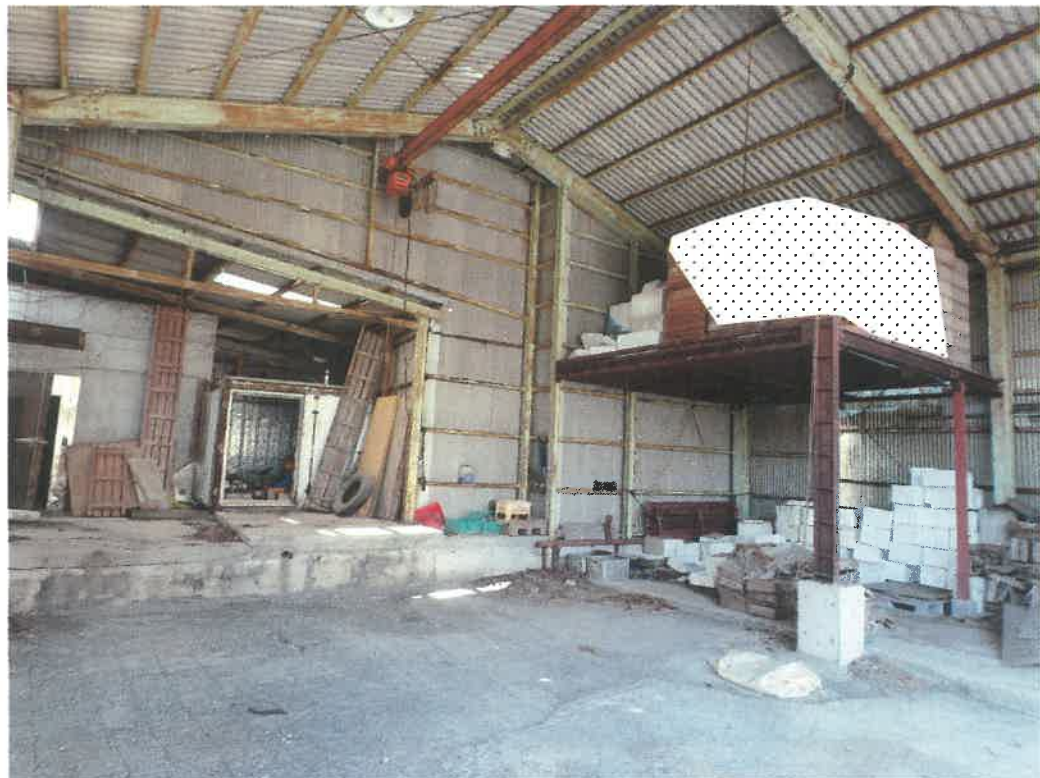
物件 1 2 建物の内部
