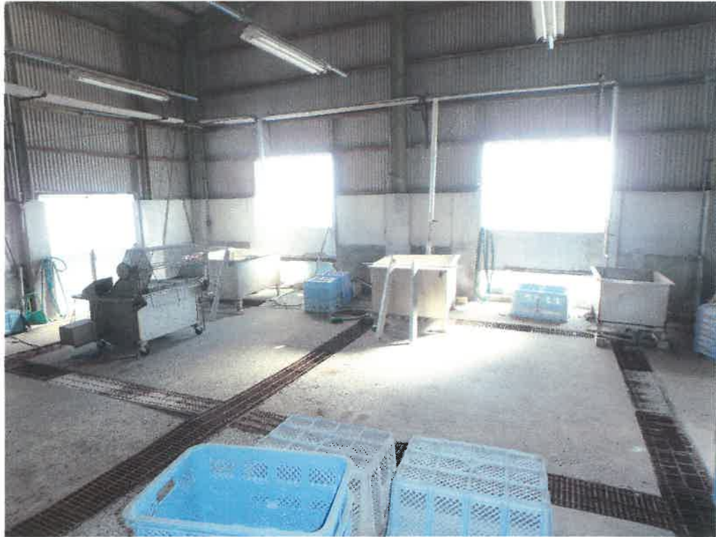
物件 1 1 建物の内部
