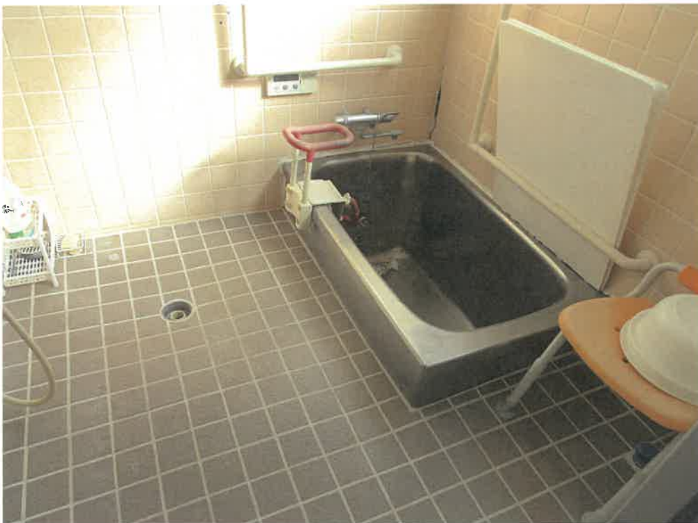
物件 2 附属建物内部 (浴室)
