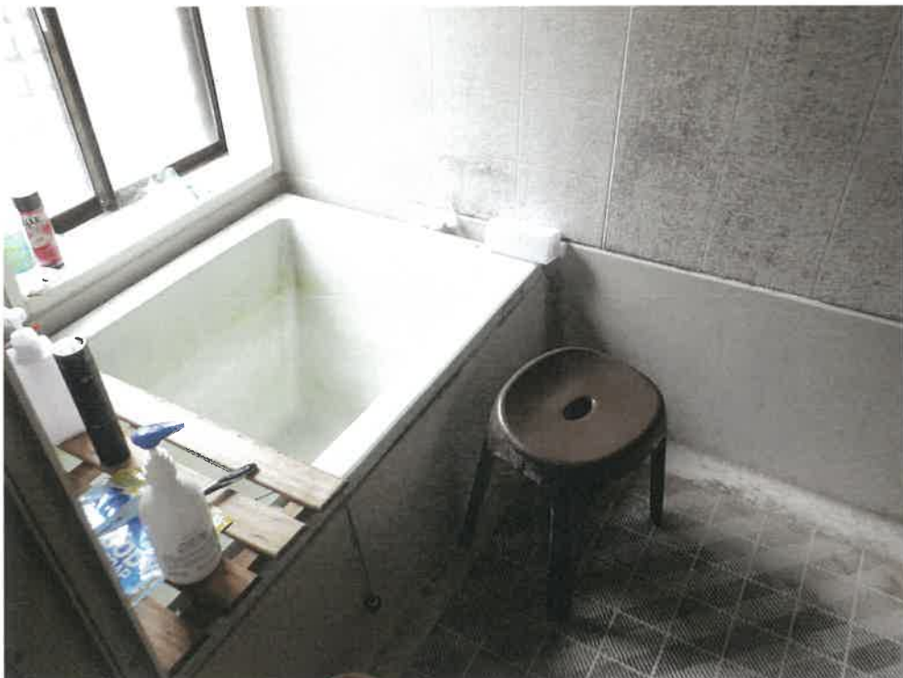
物件 2 建物内部 (浴室)
