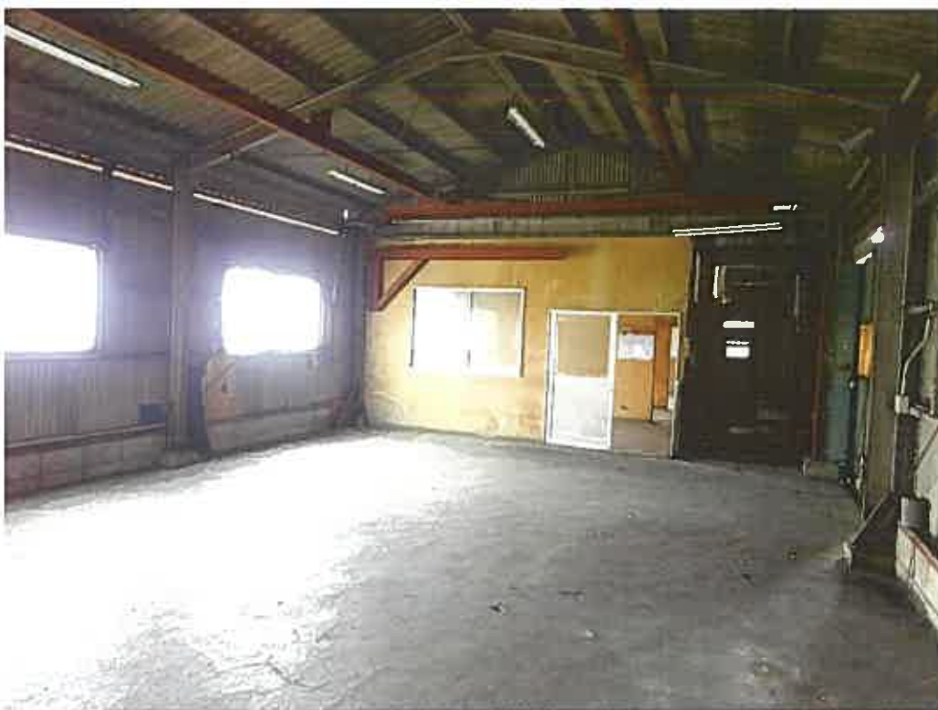
写真⑩～⑫は 物件3建物の 内部を撮影
