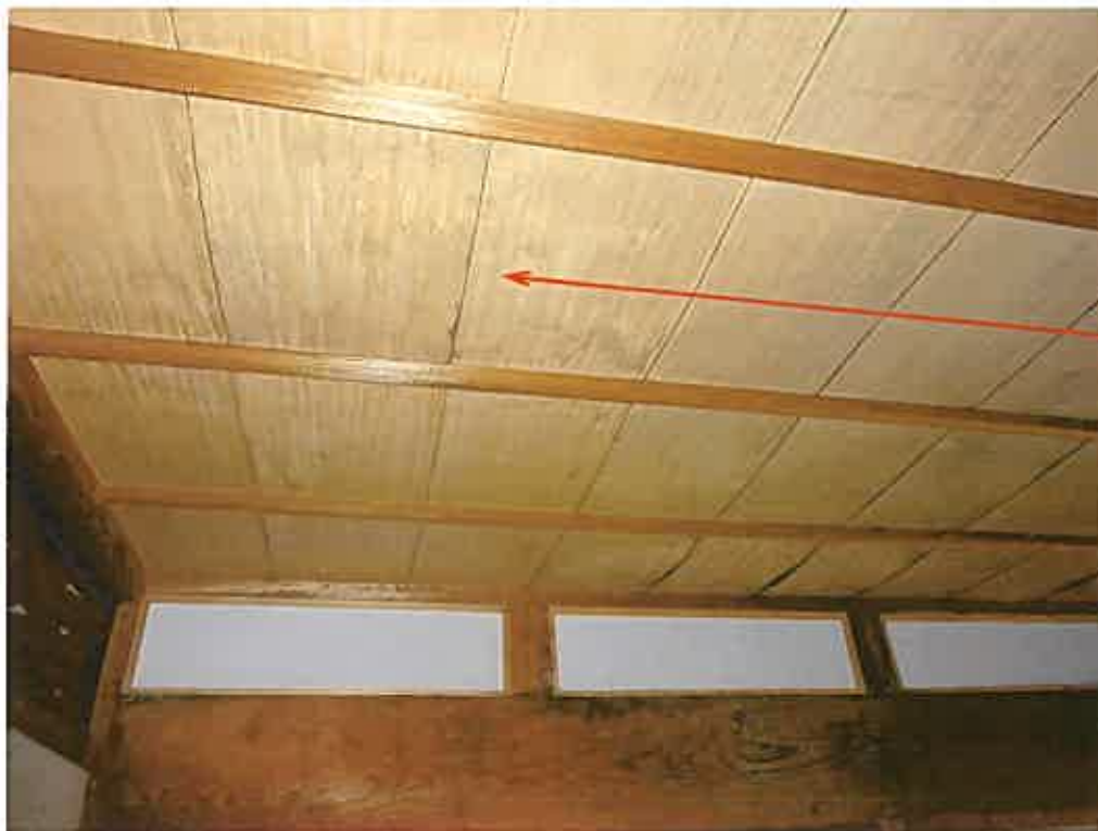
板間の天井部
