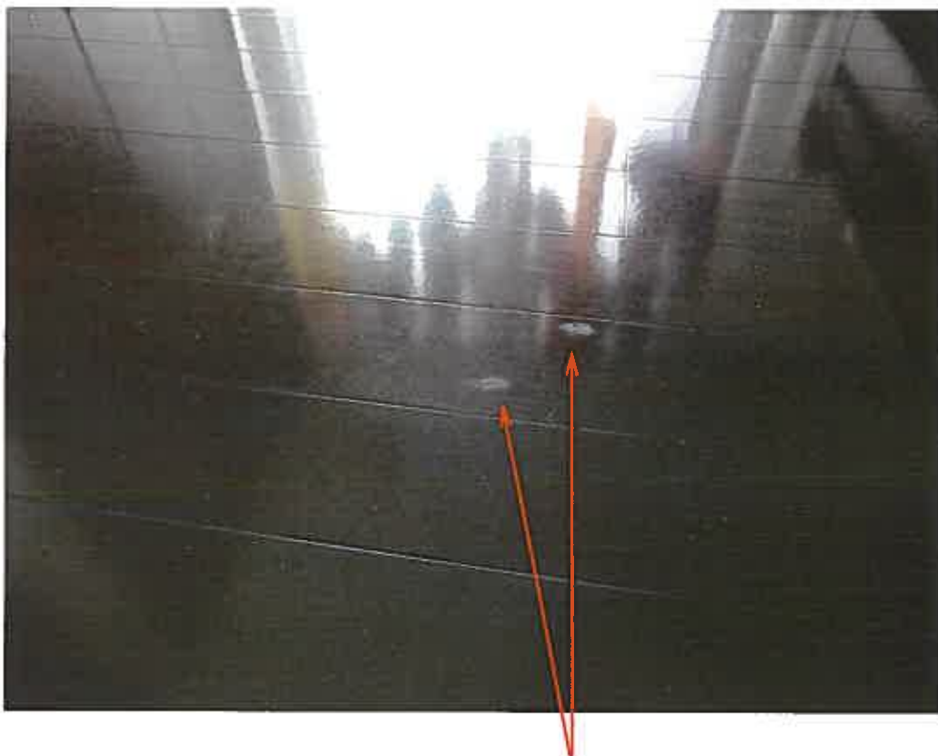
色落ちして光沢がない箇所として指示された部分
