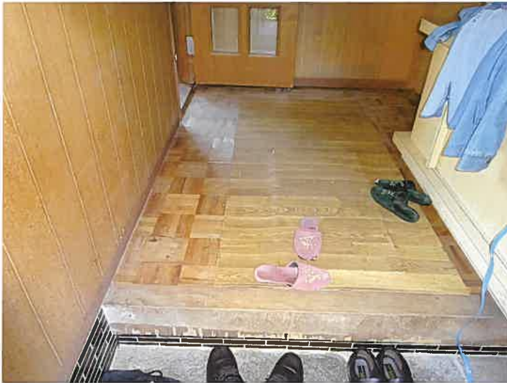
玄関ホール 床面の状況
