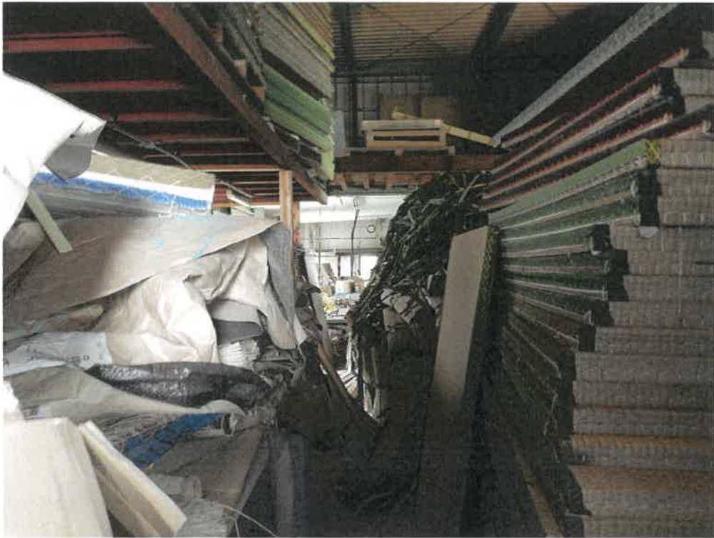
物件 6 主建物内部
