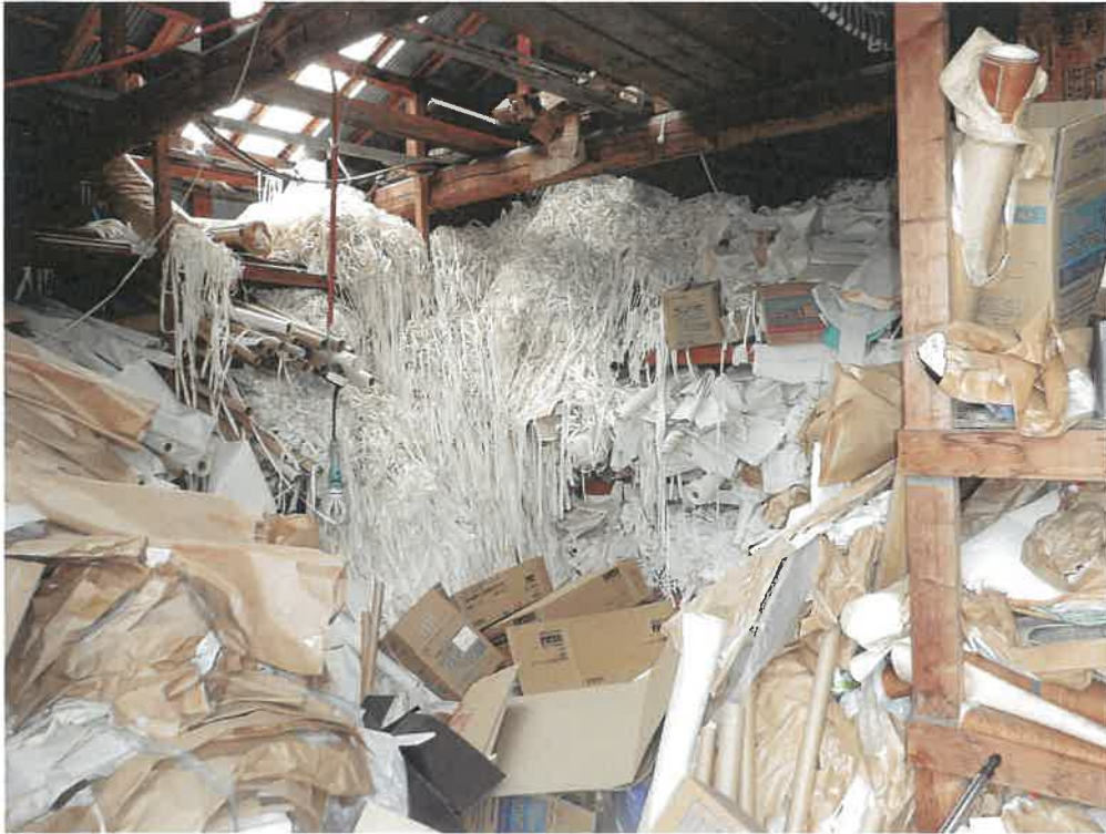
物件 6 附属建物倉庫内部
