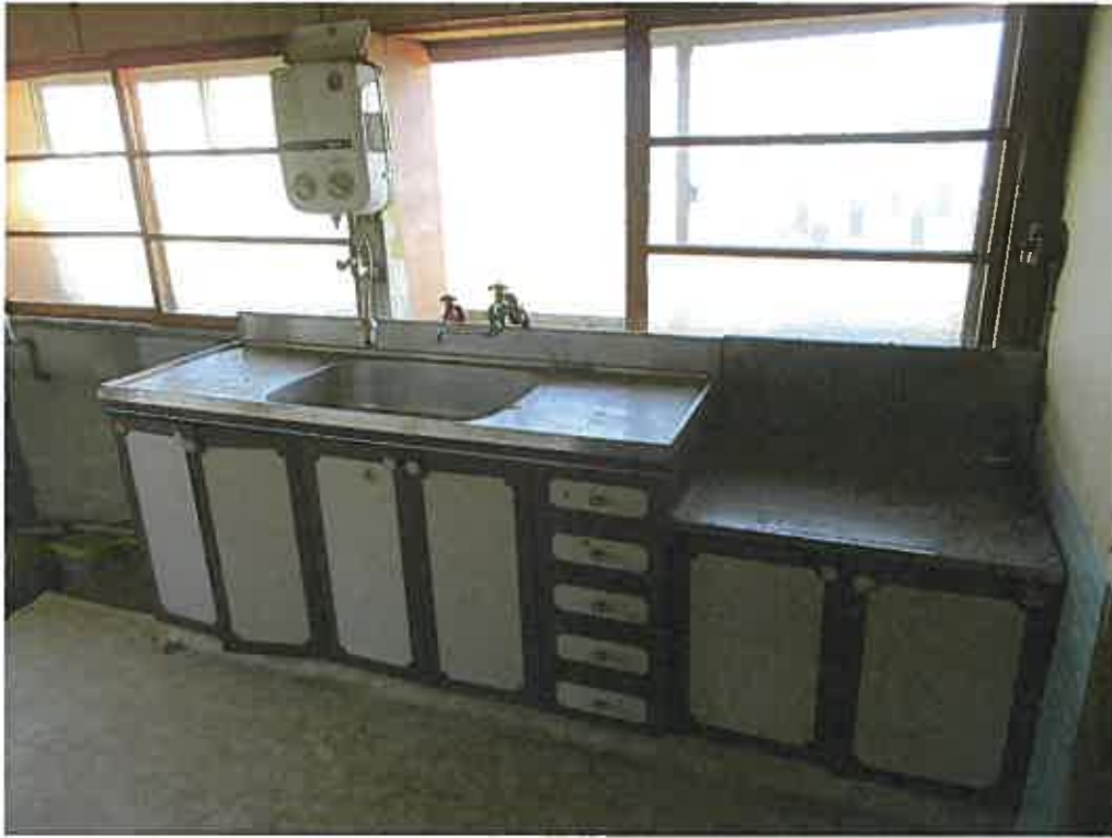
物件 3 建物内部（台所）
