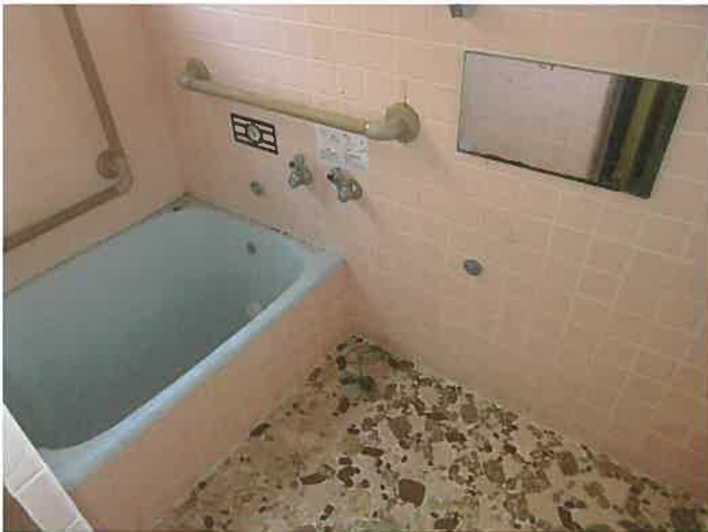
物件 3 建物内部（浴室）
