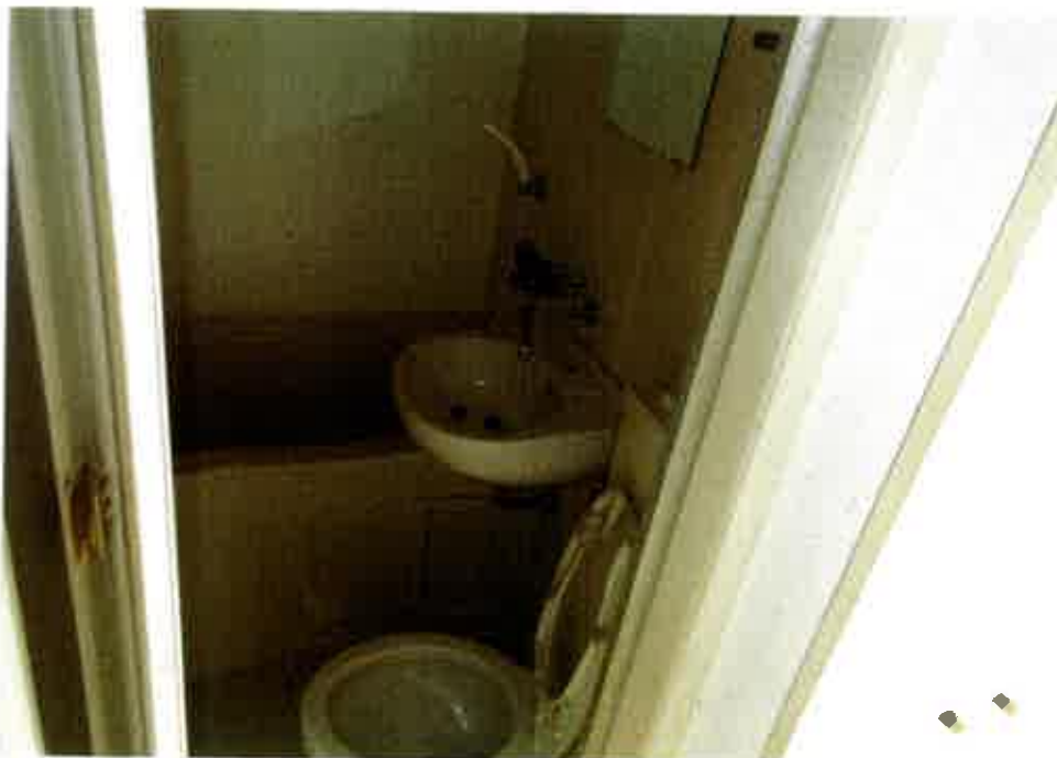
屋内の状況 (1階 106号室 ユニットバス)
