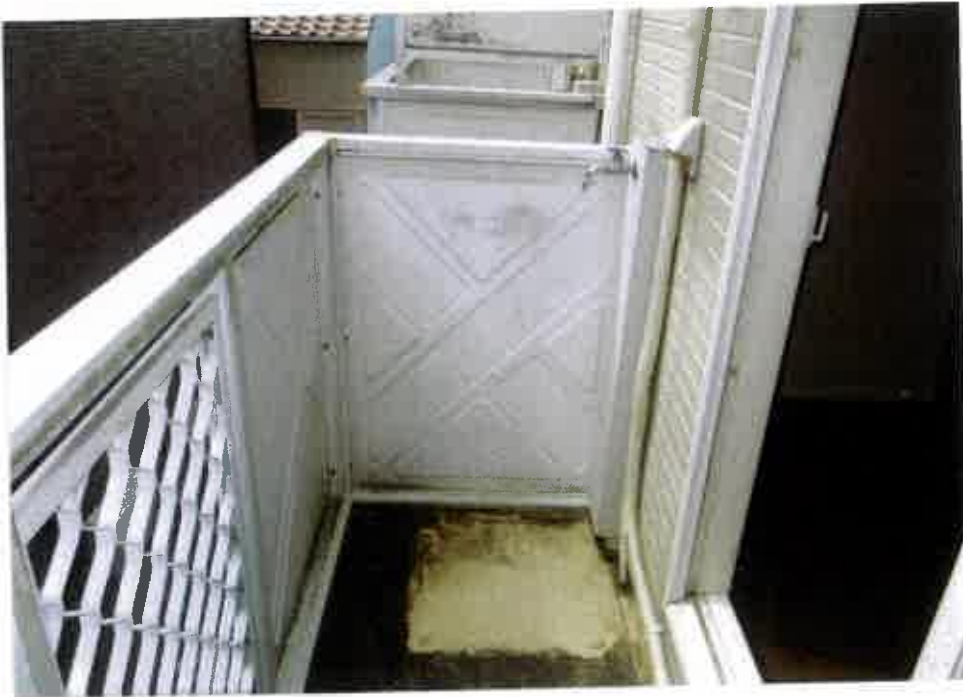
屋外の状況（2階 202号室 ベランダ）
