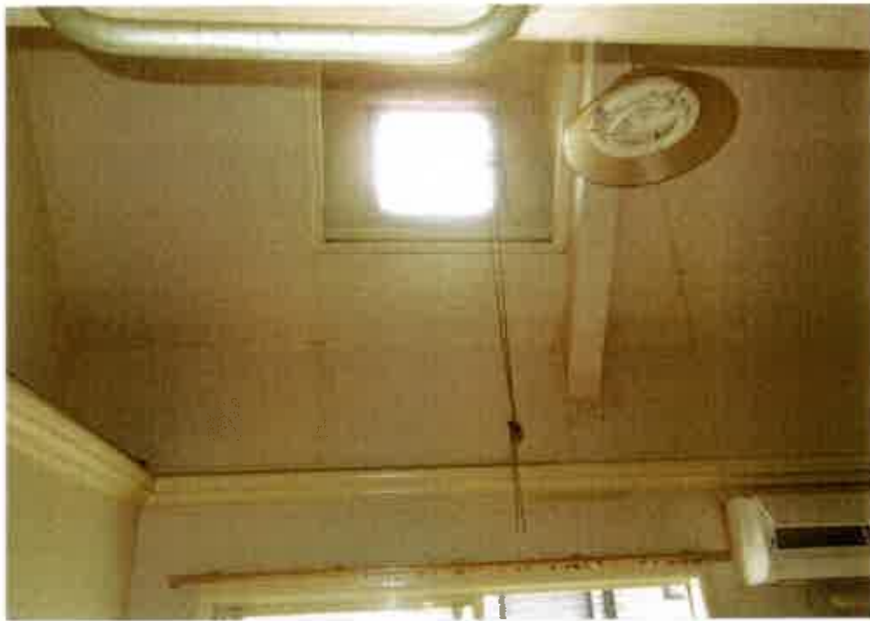
屋内の状況 (2 階 202号室 洋室 天窓)
