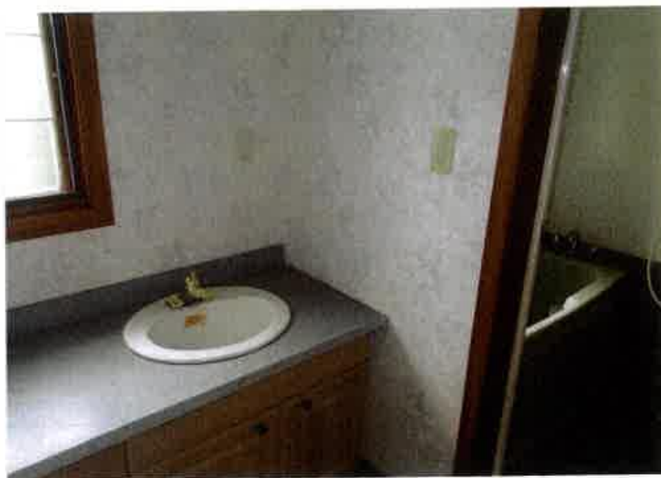
屋内の状況(3階 洗面所・浴室)
