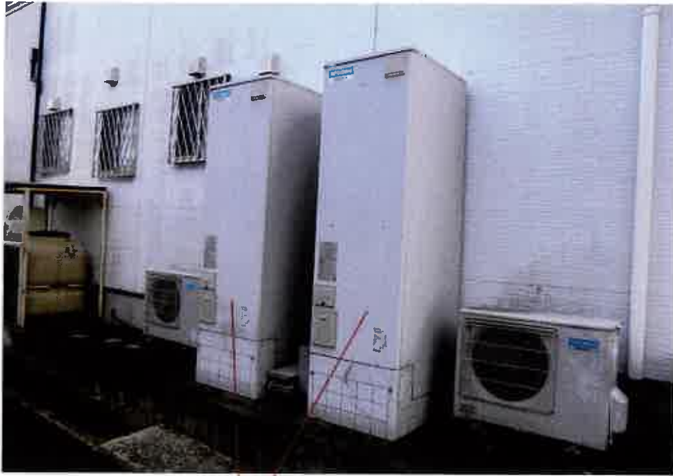
⑦屋外の状況
