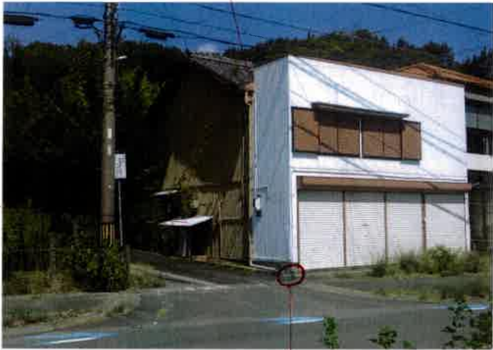
物件3建物のコンクリート製の基礎が西側道路に越境していると見受けられる場所 屋外の状況
