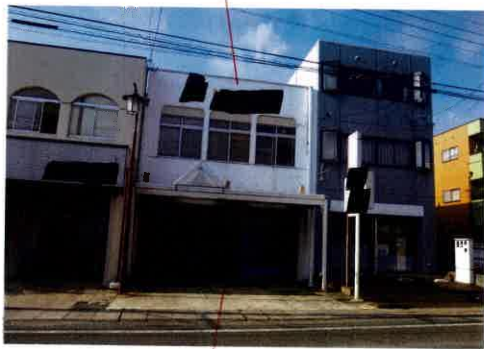
②屋外の状況 (南側から 撮影)
