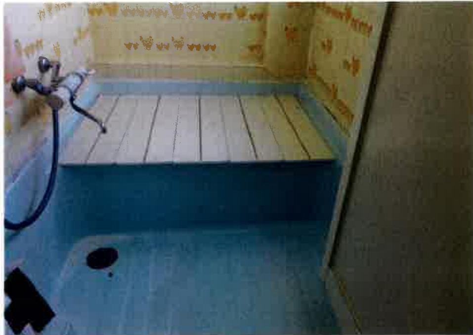
⑨屋内の状況 浴室 (物件8)
