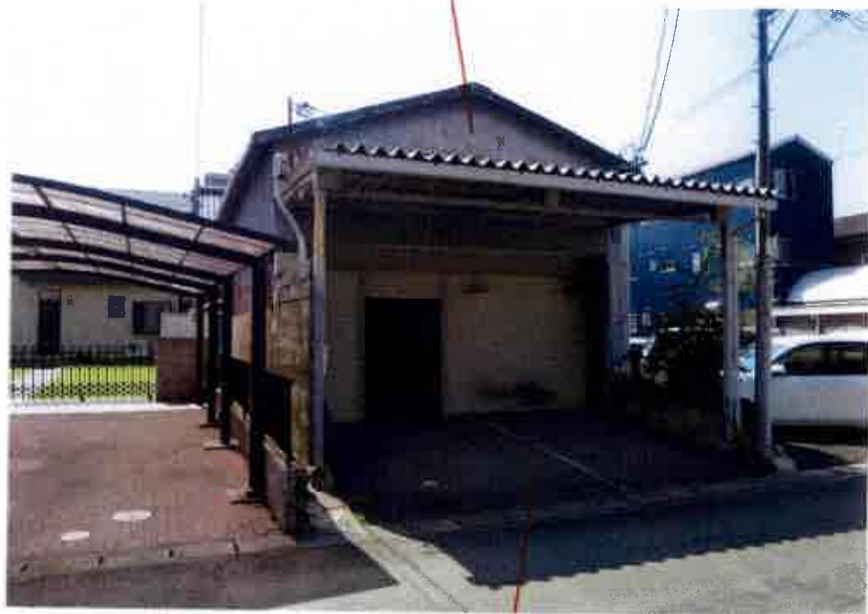
①屋外の状況 (北側から 撮影)
