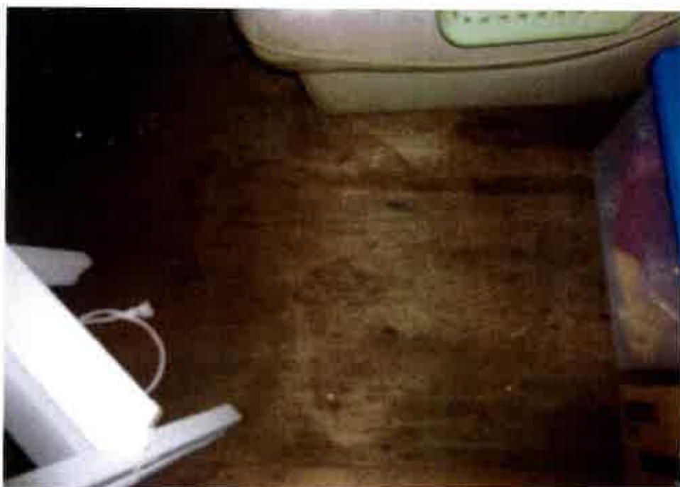
⑫屋内の状況 倉庫1の床の 状況
