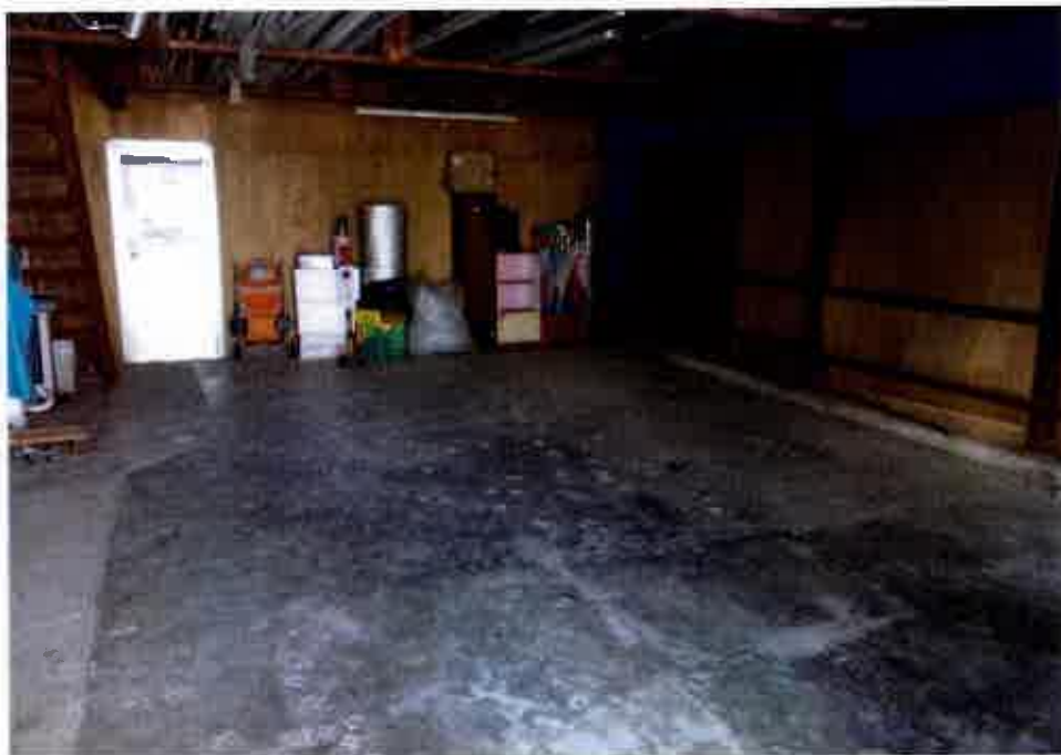
⑬屋内の状況 倉庫 1 (物件 9)
