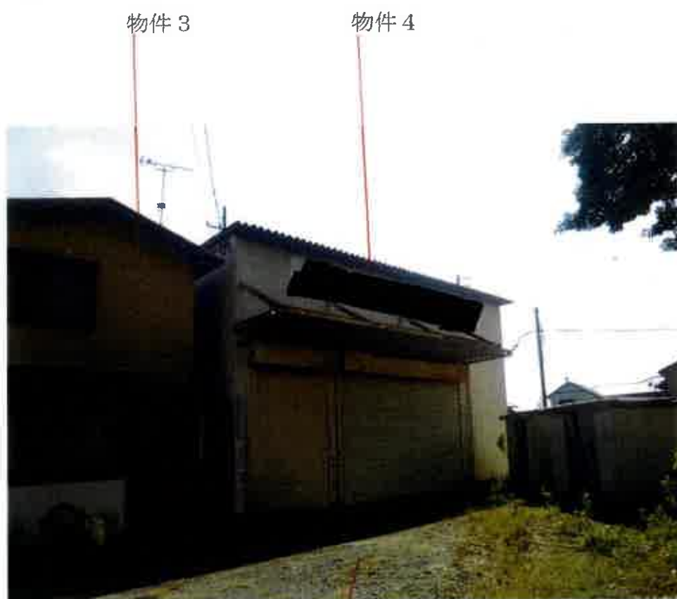
④屋外の状況
