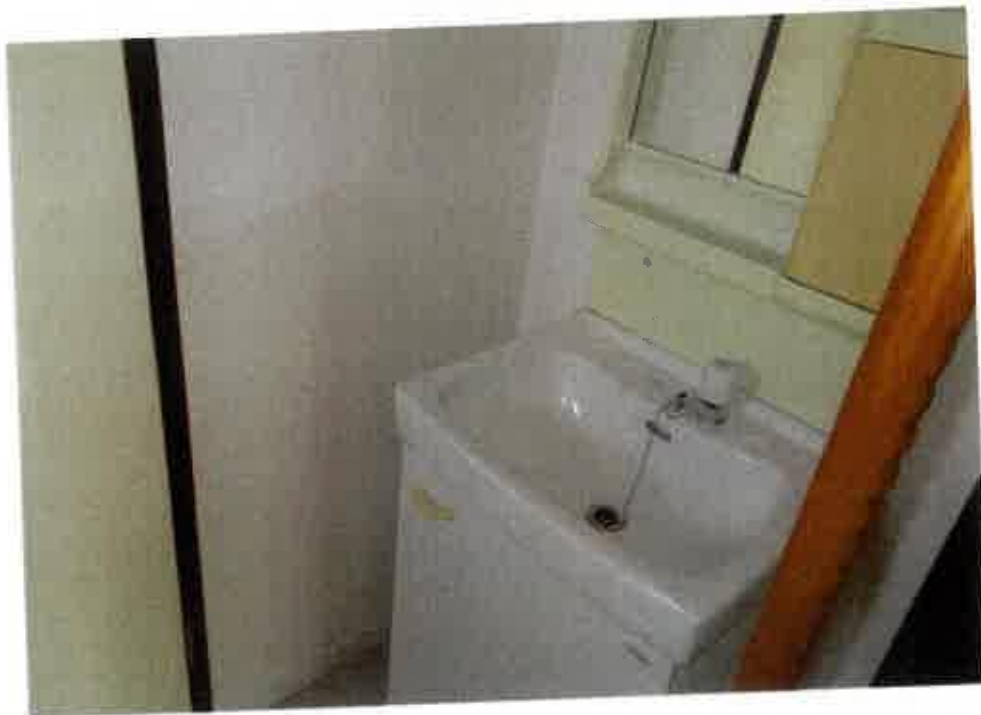
屋内の状況 (B2階 202号室 洗面)
