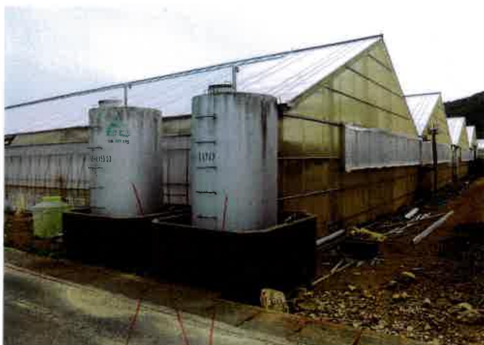
東 ②北西側境界 付近の状況
