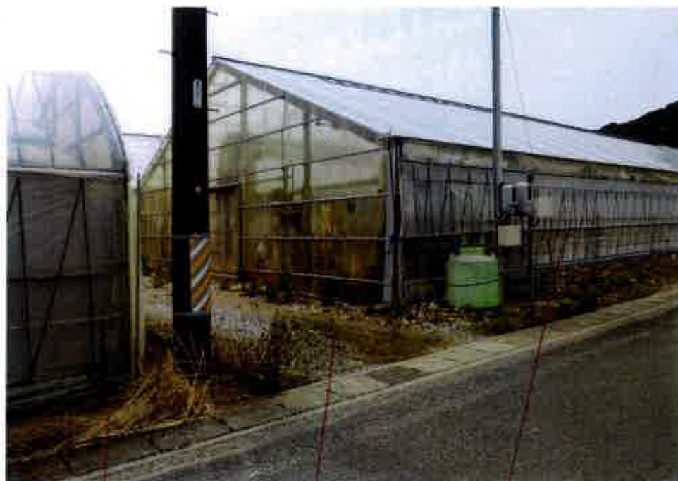
東 ①南西側境界 付近の状況
