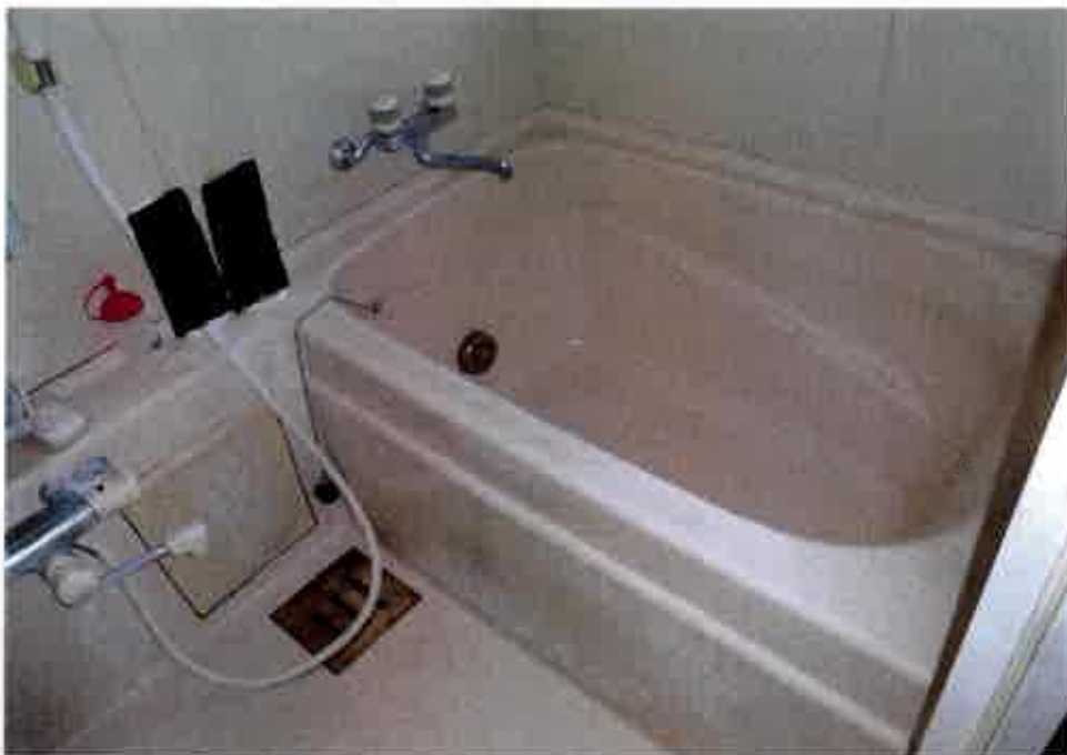
④屋内の状況 浴室
