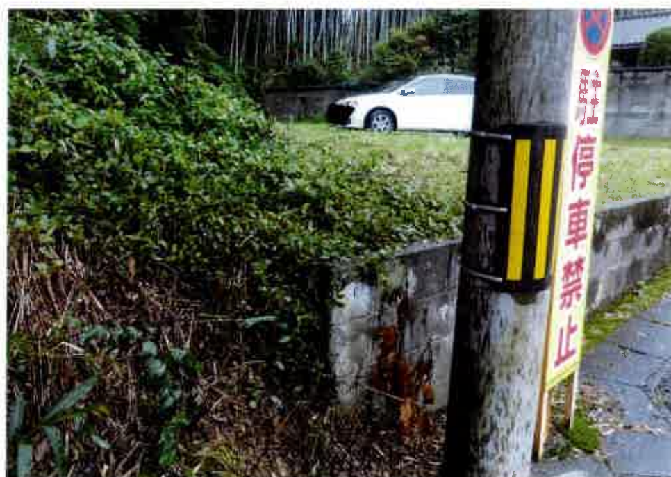
④東側境界 付近の状況
