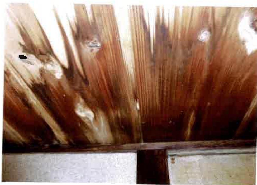
⑩屋内の状況 廊下・縁側の 天井の状況 (物件5) (主である 建物)
