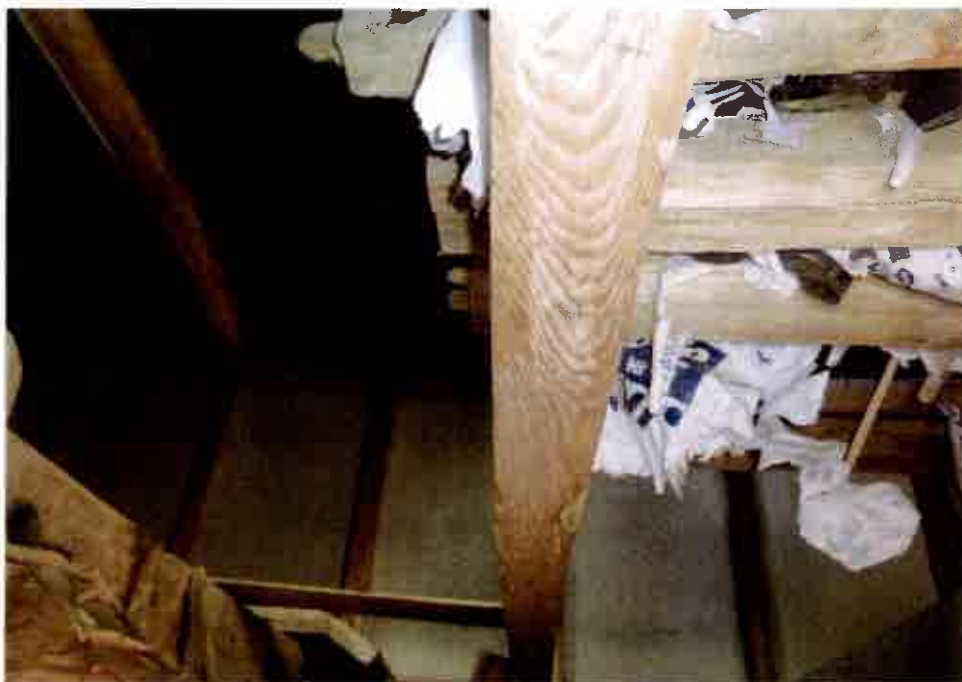
⑫屋内の状況
