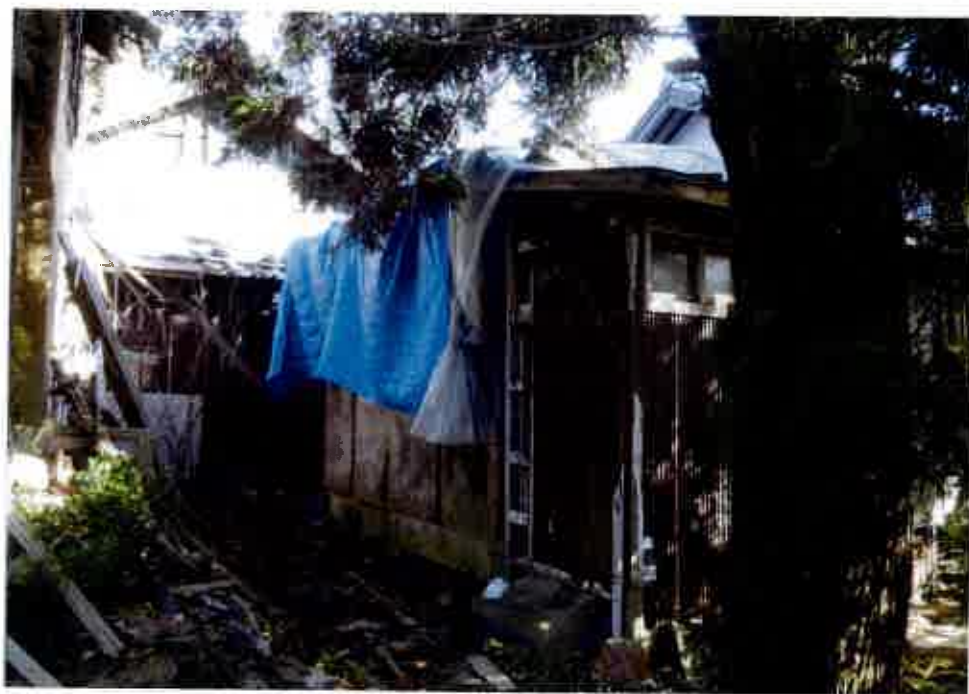
⑫屋外の状況 西側部分の 状況 (物件5) (主である 建物)
