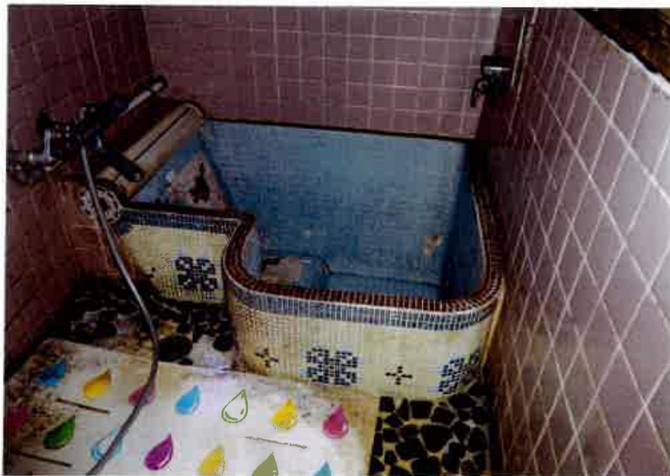
⑧屋内の状況 浴室 (物件5) (主である 建物)
