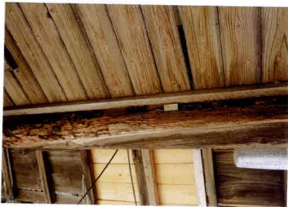
⑪屋内の状況 土間の天井 の状況 (物件5) (主である 建物)
