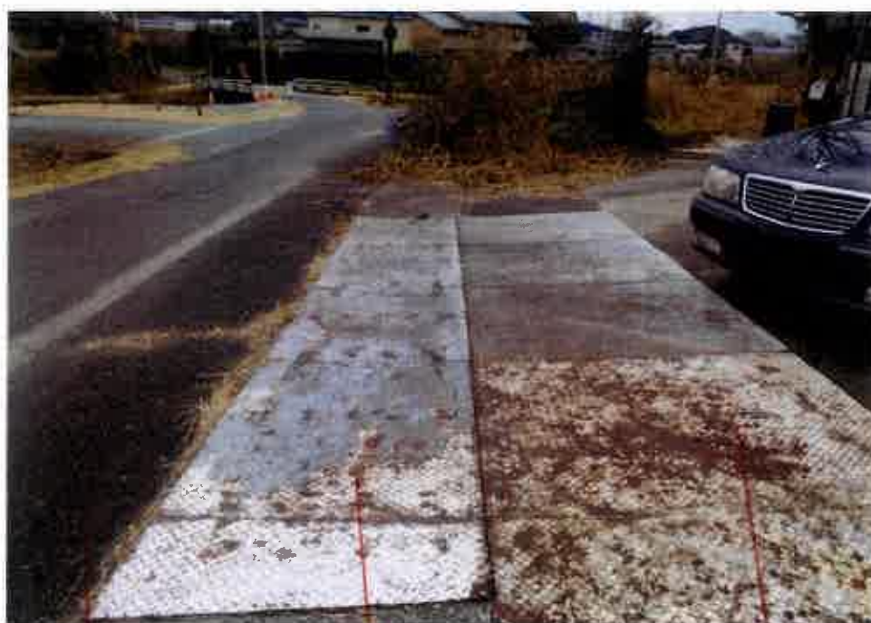
⑧屋外の状況 東側境界付近 の状況
