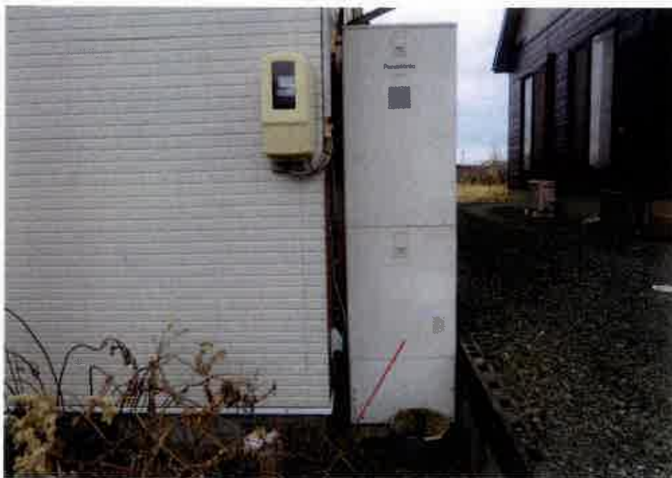
⑦屋外の状況
