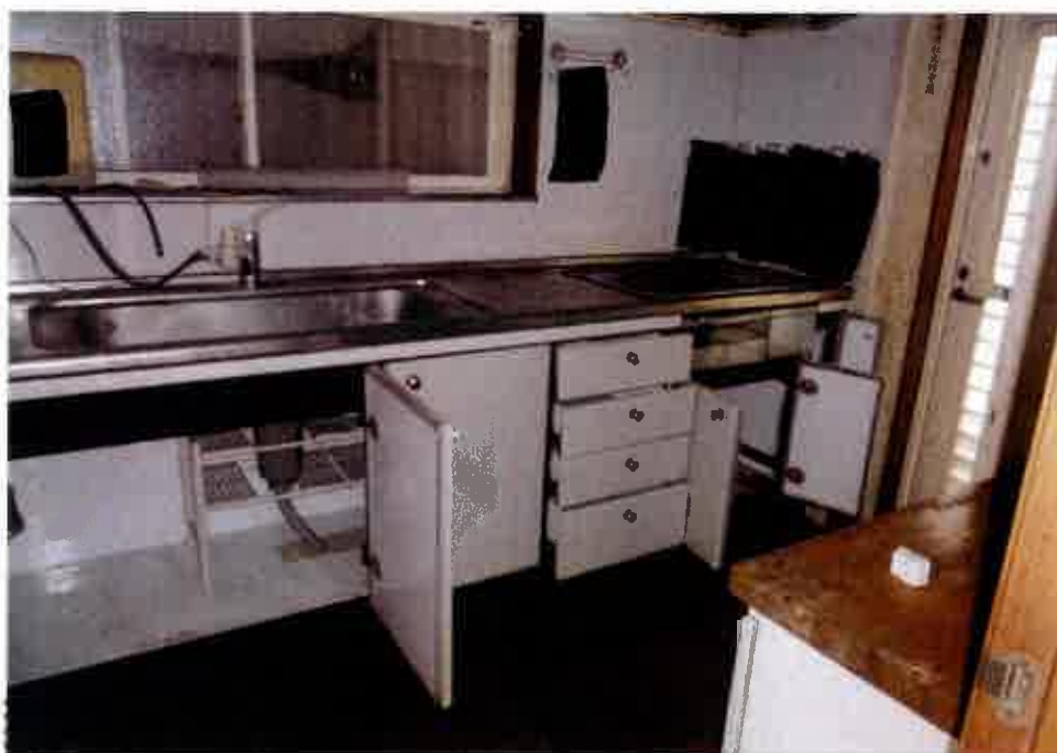
③屋内の状況 台 所 (主である 建物)
