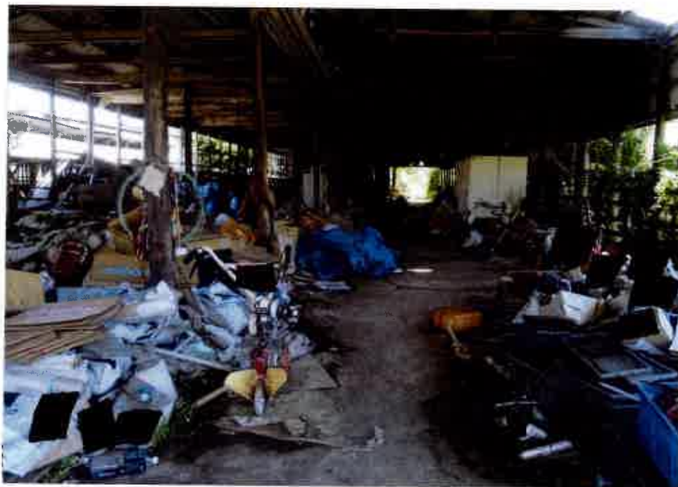
⑩屋内の状況 牛舎・倉庫 (符号3の 附属建物)
