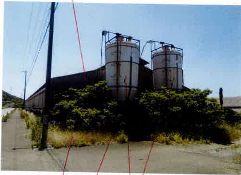
⑦屋外の状況
