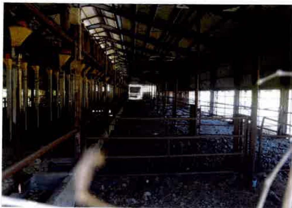
⑤屋内の状況 牛舎 1 (符号 1 の 附属建物)
