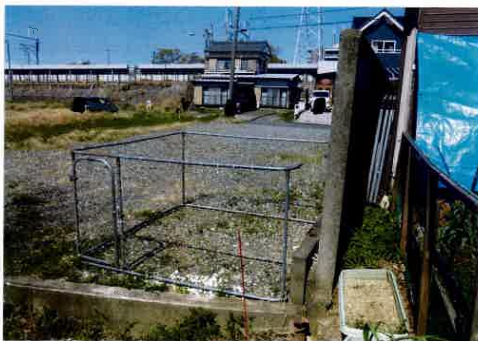
②南東側境界 付近の状況
