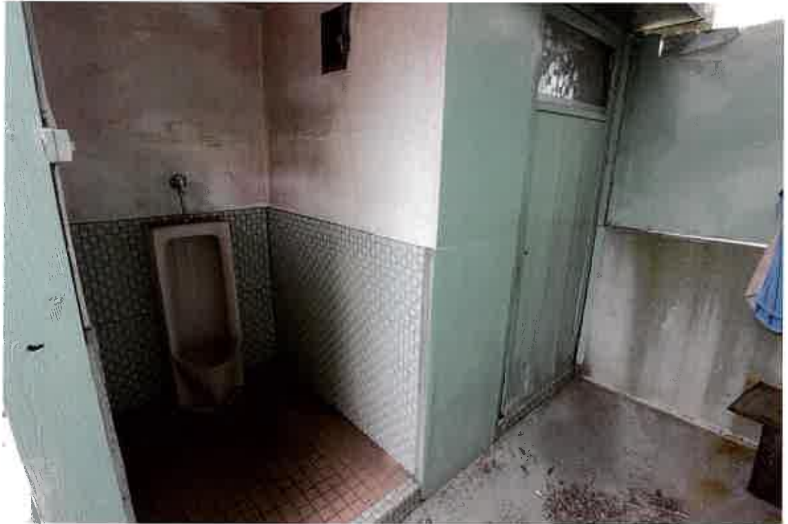
物件 4 附属建物 1 室内(便所)
