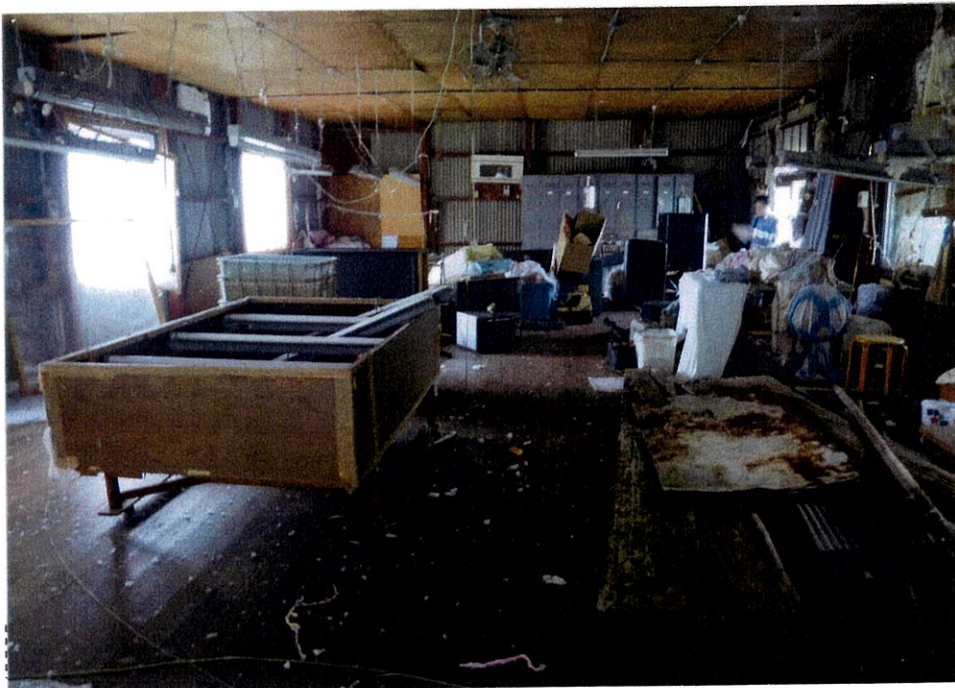
②屋内の状況
