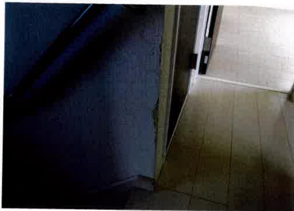
⑤屋内の状況 2階ホールの 壁の状況
