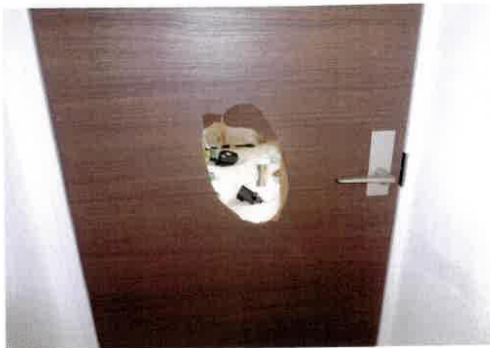
⑤屋内の状況 洋室1の扉 の状況
