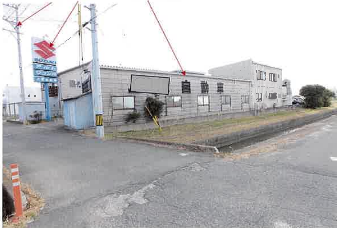
写真1 電柱 看板塔 物件4主建物
