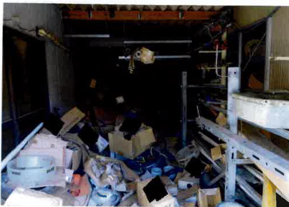
③屋内の状況 倉庫1
