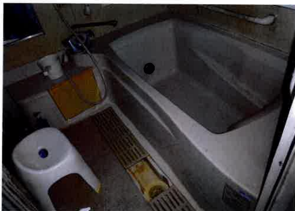
④屋内の状況 浴室
