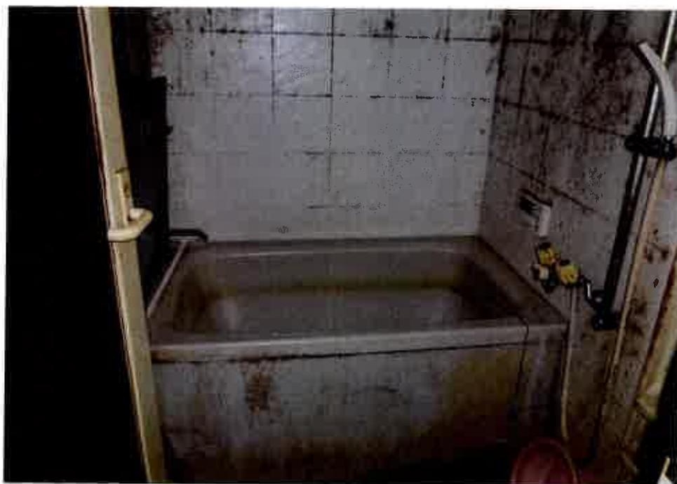
④屋内の状況 浴 室
