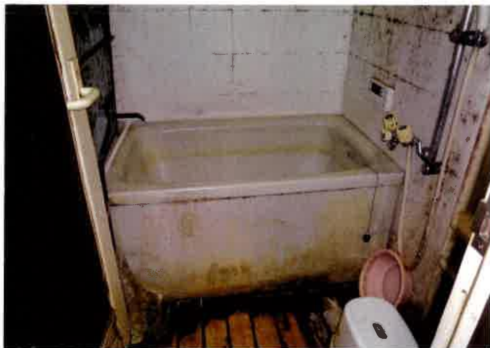
④屋内の状況 浴 室
