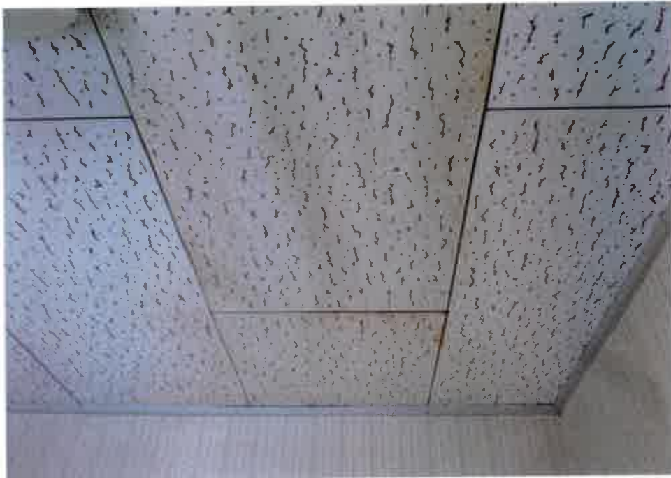
④屋内の状況 2階ホールの 天井の状況
