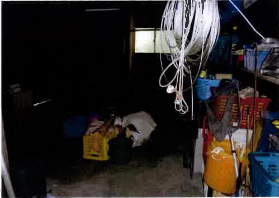
③屋内の状況 1階車庫 (物件6)
