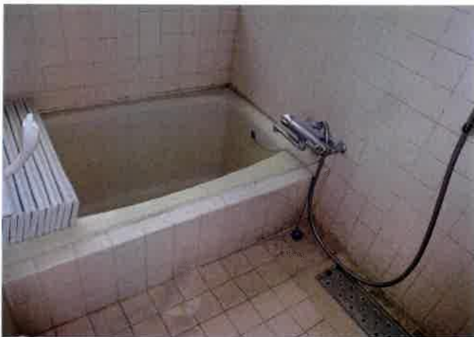
⑧屋内の状況 浴室 (物件7)
